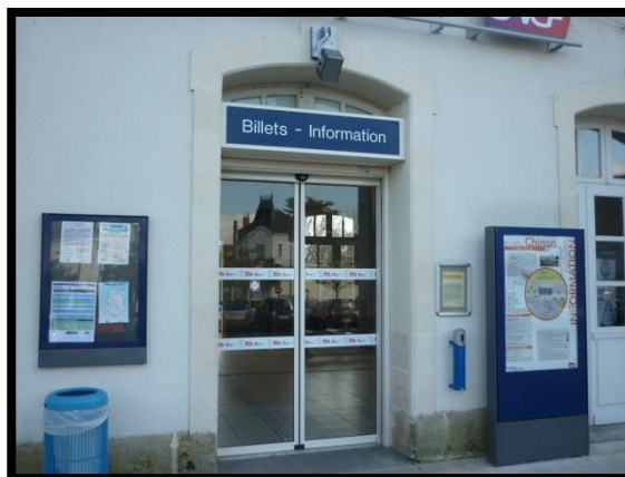
Portes automatiques d'entrée et de sortie de gare accompagnée d'une balise sonore
